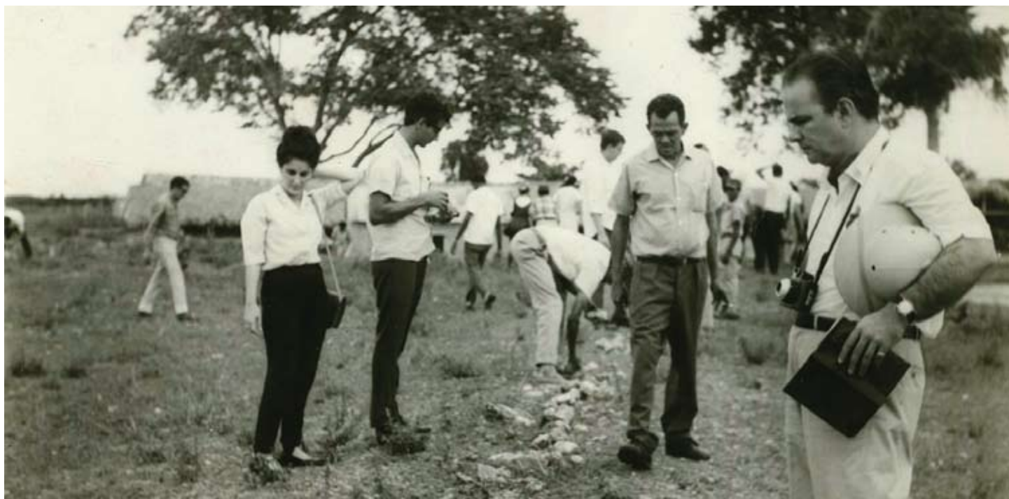
Proceso de construcción del campus de Santiago
